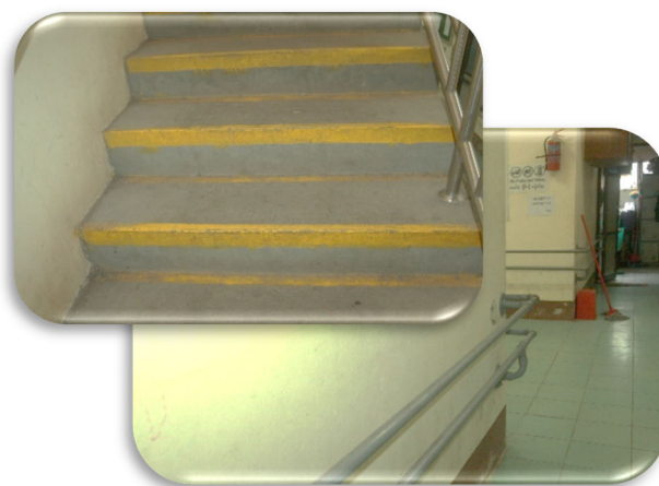
▼廊下や階段に設置された手すり
