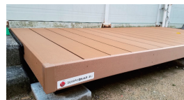
— ウッドデッキを設置 —
